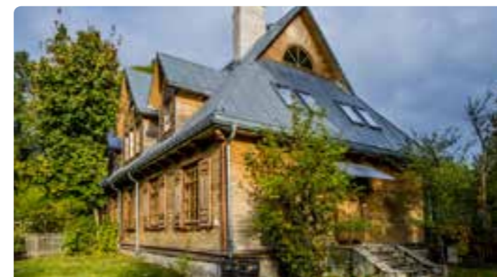
► Elewacja od strony podwórza – trzy duże okna i nadświetle w dużej lukarnie oświetlają stojący w tym miejscu duży stół
