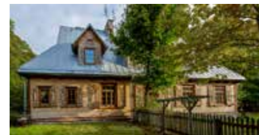
► Przedwojenna leśniczówka przed remontem. Przez lata przeszła wiele, pełniła różne funkcje. Stan dzisiejszy – udało się ją ocalić i w pełni przywrócić do życia. Dobudowane lukarny pozwoliły na stworzenie nowoczesnego loftu na poddaszu
